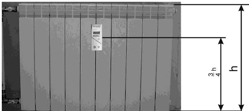
Рис. 1.1. Установка измерителя ИНДИВИД.
